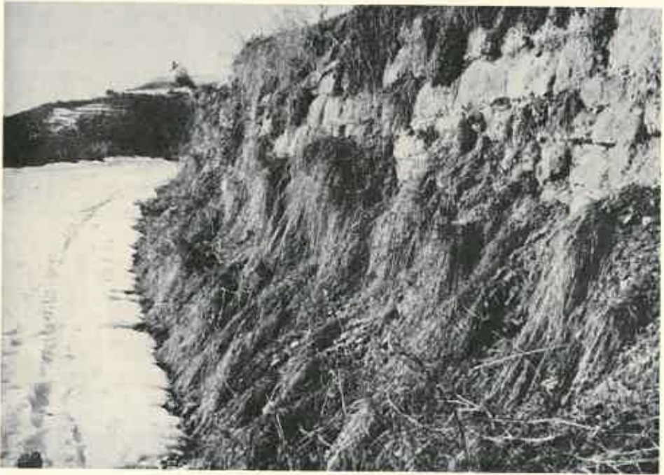
Abb. 7. Von abgeschwemmter Feinerde gebildeter Erdwall am Fuß einer Weinbergmauer. Am Weg von Hirschau zur Wurmlinger Kapelle im Februar 1963. Photo Görs
